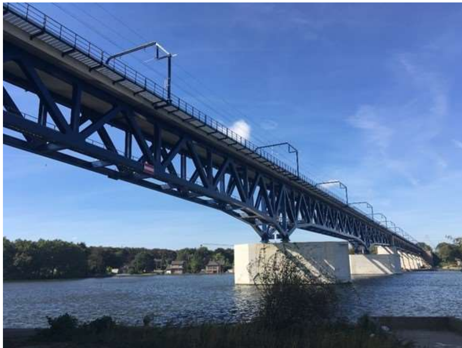
"Viaduc des Allemands" L24 over de Maas
